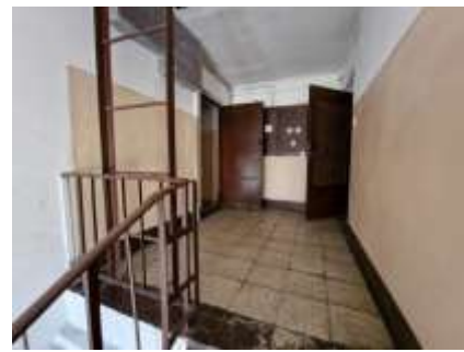
5.stāva kāpņu telpa
